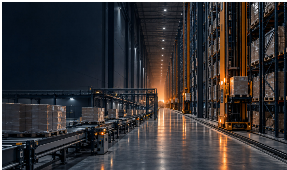
Esempio di magazzino autoportante (MAV)
